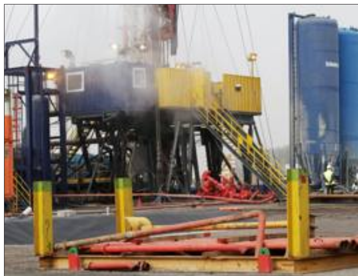
Dans le nord de l'Alsace, un puits de 2 500 m vient d'être foré pour alimenter en eau à 170° l'usine Roquette. Archives Jean-Marc Loos
